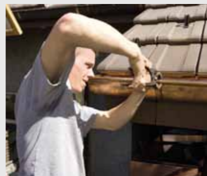
Montage des éléments de fixation Tuyaux de descentes, chéneaux, recouvrements de murs, etc.: tous ces éléments doivent être installés soigneusement.
