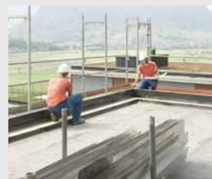
Relevé des mesures Pour préparer leur travail, les ferblantiers prennent des mesures directement sur le chantier. Lire ou dessiner un plan demande une bonne vision de l'espace.
