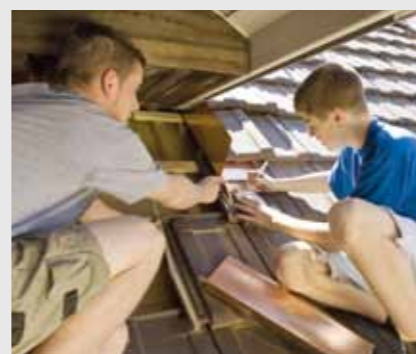
Montage sur le chantier Les ferblantiers terminent leur travail par le montage des tôles profilées. Ils le font avec soin et précision: leur travail restera visible pour longtemps.
