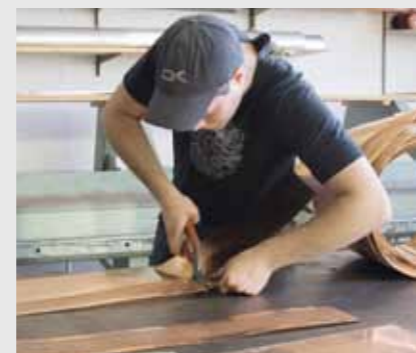
Travail manuel à l'atelier Le ferblantier découpe la tôle selon le développement de la pièce, en veillant à produire un minimum de déchet.
