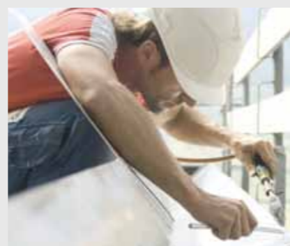
Garantir l'étanchéité Les raccords entre les garnitures doivent être rendus étanches. Des techniques de brasage tendre ou de brasage fort sont alors employées.
