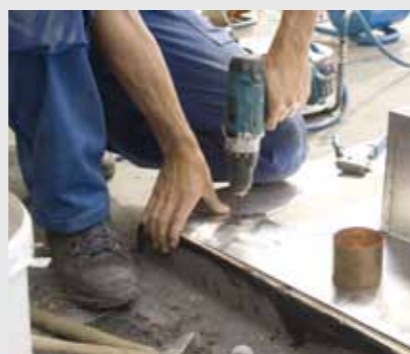
Assemblage des tôles A l'atelier et sur le chantier, il y a toujours des tôles à assembler. Il existe différentes techniques: assemblage par rivetage, agrafage, etc.
