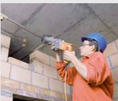
Montage des colonnes montantes L'eau froide et l'eau chaude sont amenées aux étages par la colonne montante. Pour le montage, de nombreux outils sont utilisés.
