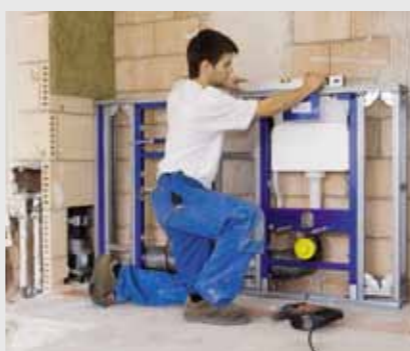
Montage devant un mur Les installations murales (en applique) se montent facilement et à peu de frais. Les professionnels suivent les instructions de montage des fabricants.
