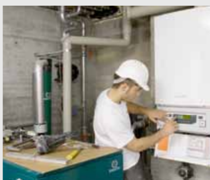
Installation d'appareils de chauffage au gaz Les installateurs et installatrices sanitaires disposent des connaissances de base pour poser en toute sécurité une installation de gaz naturel.
