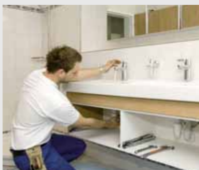
Montage des appareils Les installateurs sanitaires achèvent leur travail avec la pose et le raccordement des appareils et des robinetteries. Désormais, toute éraflure se verra.
