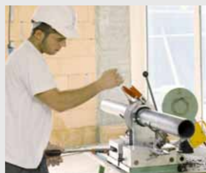
Travail à l'établi A l'établi, les installateurs sanitaires effectuent des raccordements spéciaux: assemblage par soudage, par collage, etc.
