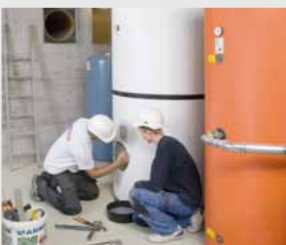
Mise en service d'un chauffe-eau Le raccordement, la vérification et la mise en service font partie des diverses tâches.
