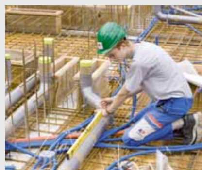
Travaux de pose pendant le gros œuvre Au stade du gros oeuvre, les professionnels posent les tuyauteries, notamment d'eau froide, d'eau chaude et d'eaux usées. Ce travail est éprouvant.
