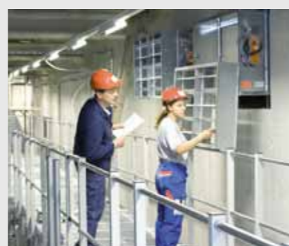
Montage des différents appareils Les professionnels veillent à respecter les directives de sécurité, notamment en installant des clapets coupe-feu.
