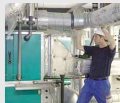
Installation d'un tuyau de ventilation Les constructeurs d'installations de ventilation respectent les normes de qualité: l'installation doit être étanche et sans ponts phoniques.
