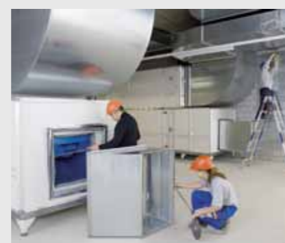
Montage d'un monobloc Le cœur des grosses installations de ventilation s'appelle le «monobloc», ou «CTA» (centrale de traitement d'air). C'est là que l'air est traité.
