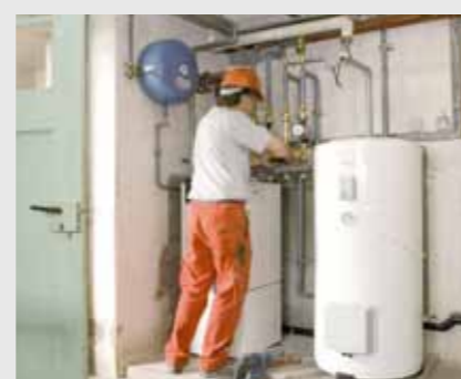
Stockage de la chaleur Il existe plusieurs moyens de stocker la chaleur: accumulateurs d'eau de chauffage, accumulateurs techniques, etc.
