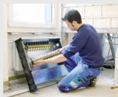
Installation des appareils Les installateurs en chauffage peuvent placer des thermostats, des capteurs et des vannes de réglage, d'après les instructions de montage du fournisseur.
