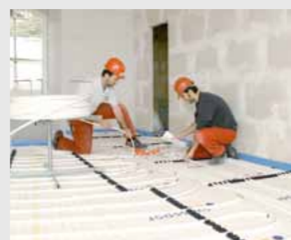
Pose du chauffage au sol Les tuyaux du chauffage au sol sont posés en serpentins sur les plaques isolantes préalablement installées, dans le plus strict respect du plan.
