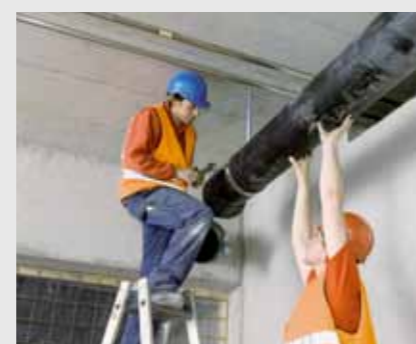
Montage des tuyauteries Les tâches essentielles des installateurs en chauffage comprennent le montage des tuyaux de chauffage, des appareils et de la robinetterie.
